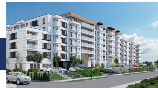
Widok od strony ulicy
