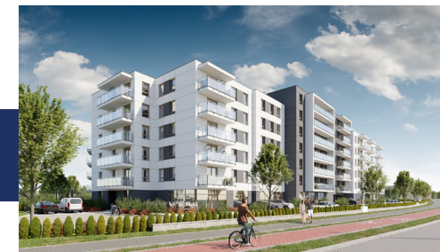
Widok od strony ulicy
